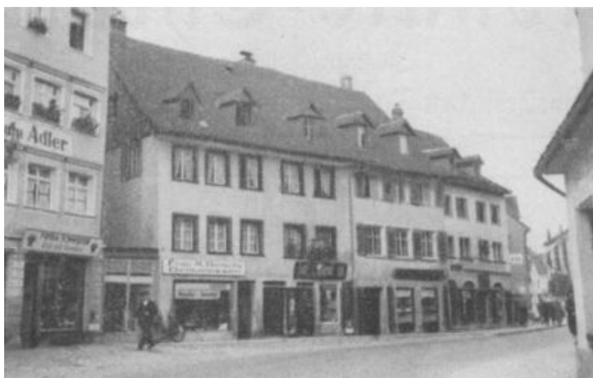
Die alten Häuser an der Hauptstrasse 91, 93, 95 gegen Westen
