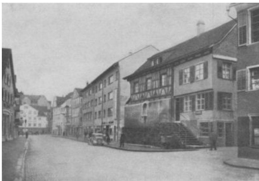
Das Trischli an der Hauptstrasse 97 in Roschach von Westen gesehen
