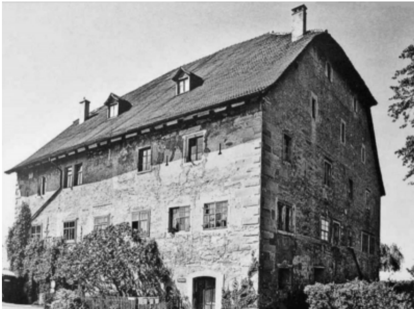
Gredhaus, Steinach, Erbaut 1473.
